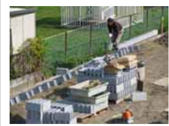
18年11月 敷地周囲にブロック塀
